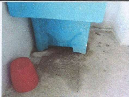
Foto 1: Sustitución e instalación de pila de cemento de dos lavaderos
