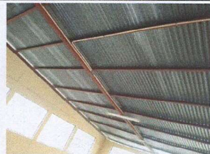
Foto 5: Sustitucion de cubierta de lamina
