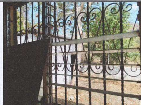
Foto 2: Mantenimiento (lijado y pintado) a 35 M2 de balcones.
